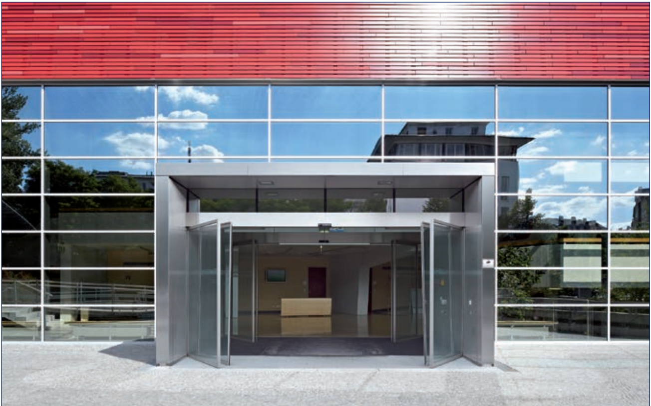
Hörsaalzentrum Klinikum rechts der Isar, Munich, Germany (photo: Robert Sprang)
